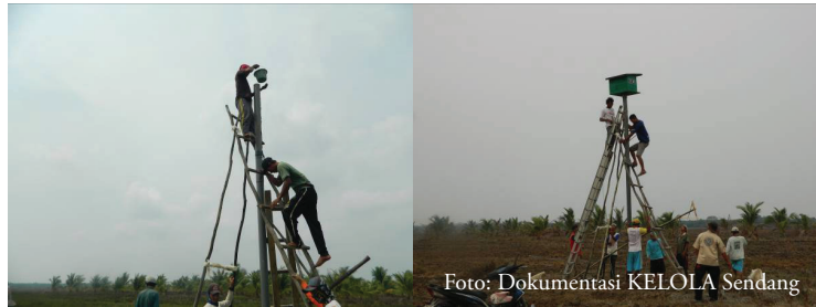
GAMBAR 3.11 Pemasangan Nest Box dan Tenggeran
